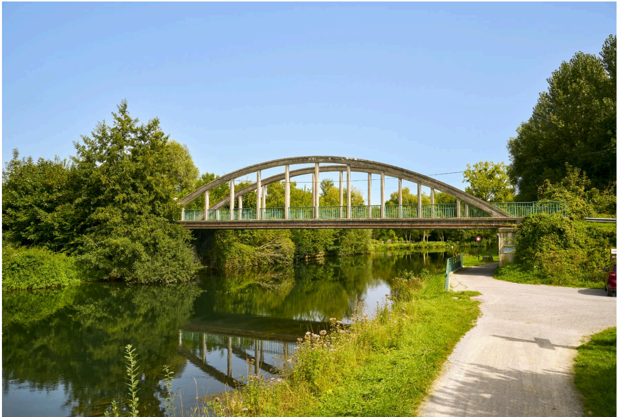
Pont entre Fontaine-sur-Somme et Cocquerel, vue prise depuis l'ouest.
