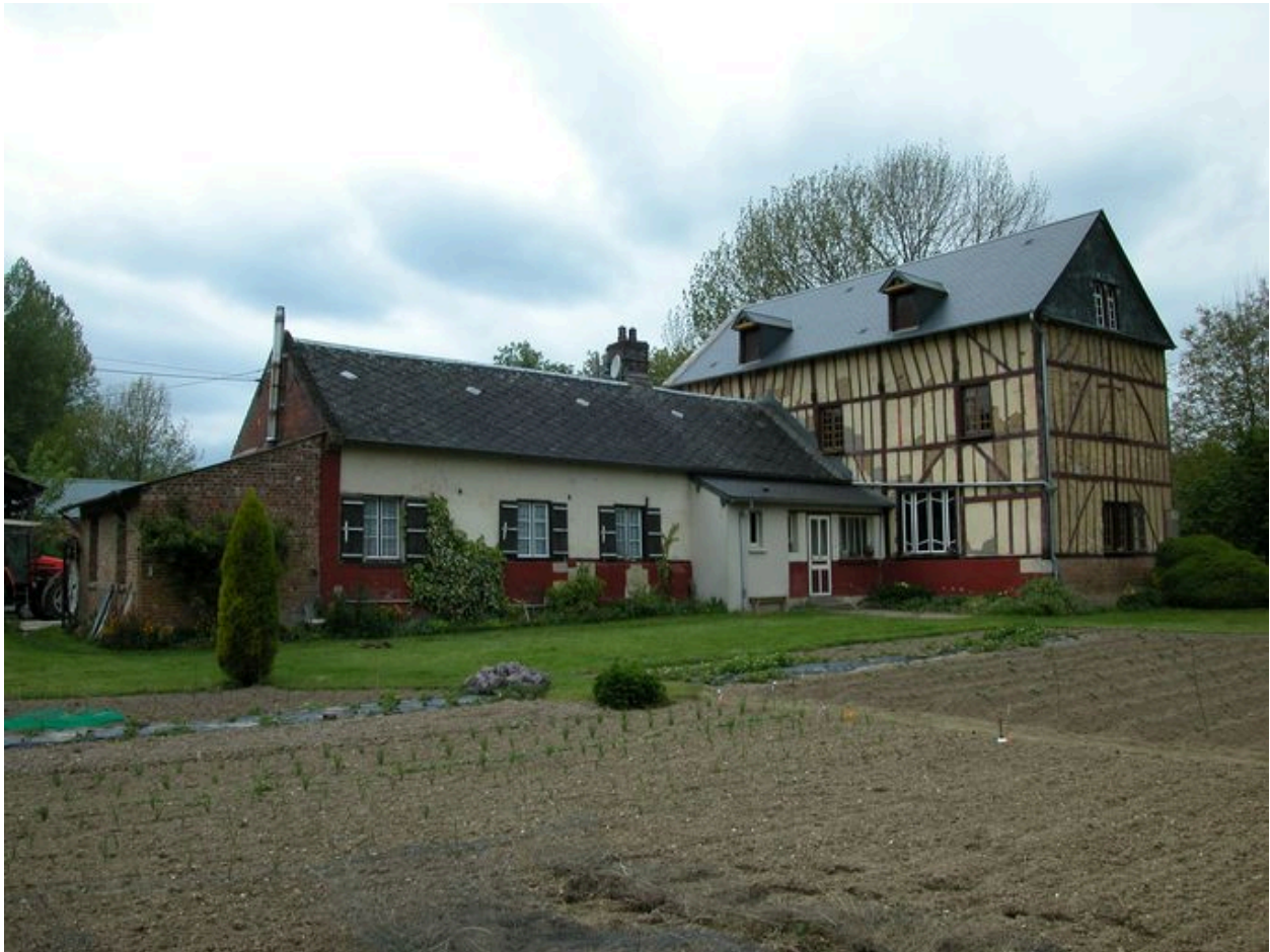
Vue d'ensemble du moulin à blé et de l'habitation en retour.
