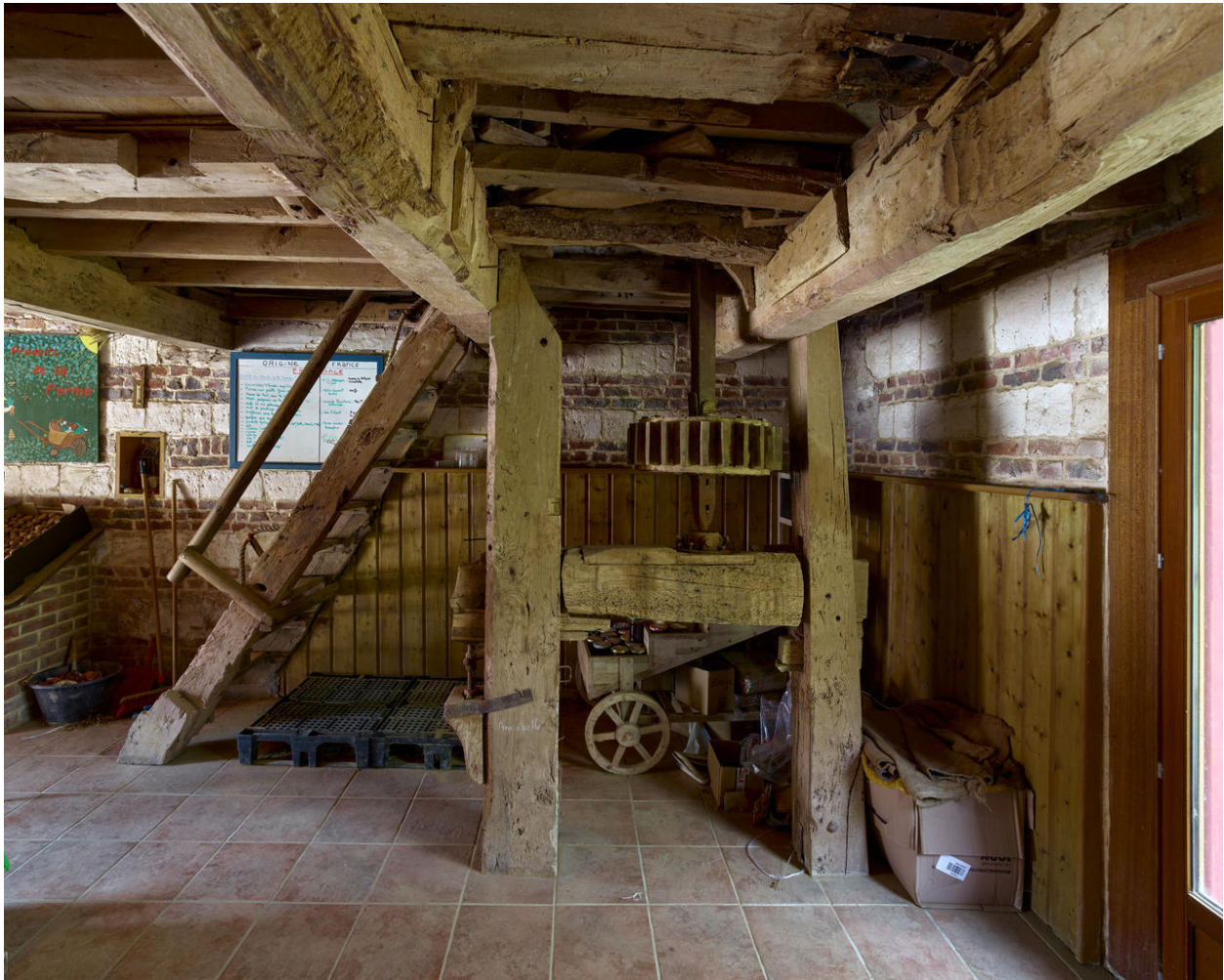
Vue du beffroi et de la lanterne, vestiges des mécanismes de transmission du moulin.
