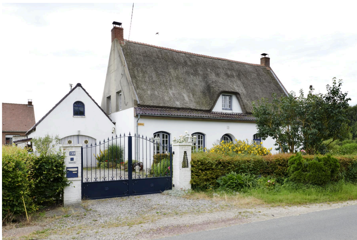
Façade principale et garage.
