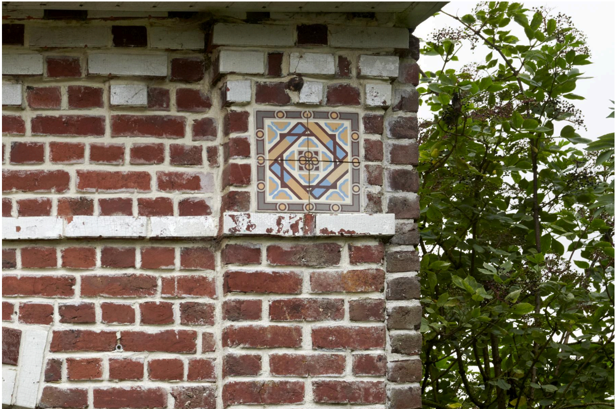
Détail décoratif, carreau de faïence inséré dans la maçonnerie.
