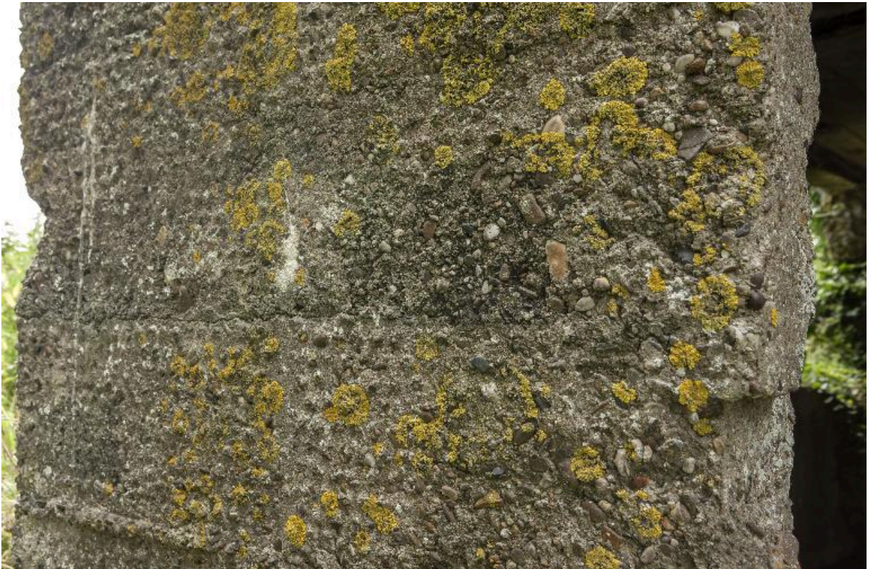
Casemate a), élévation ouest, empreinte de grillage sur le béton
