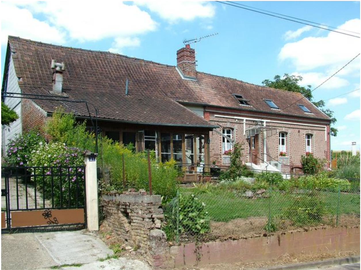
Maison, 19 rue de Long, 1ère moitié du 20e siècle.
