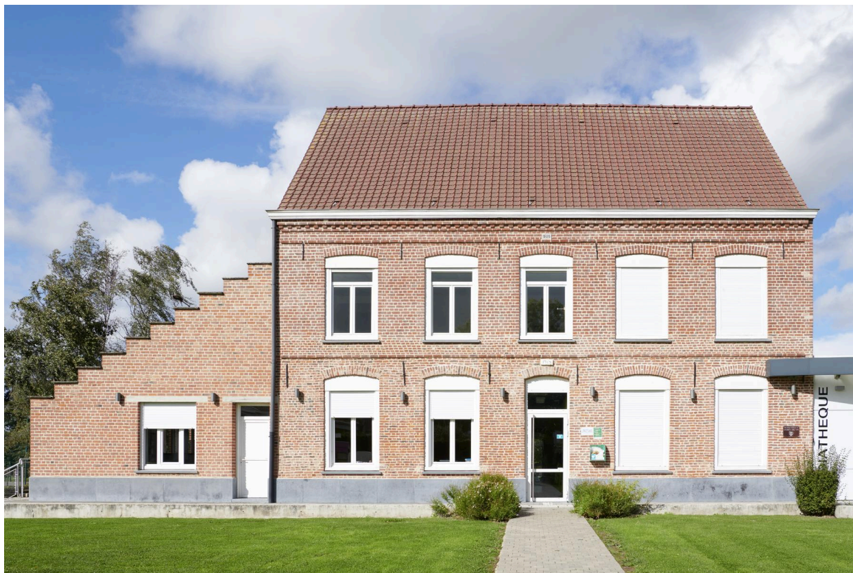
Façade principale (sud-est).
