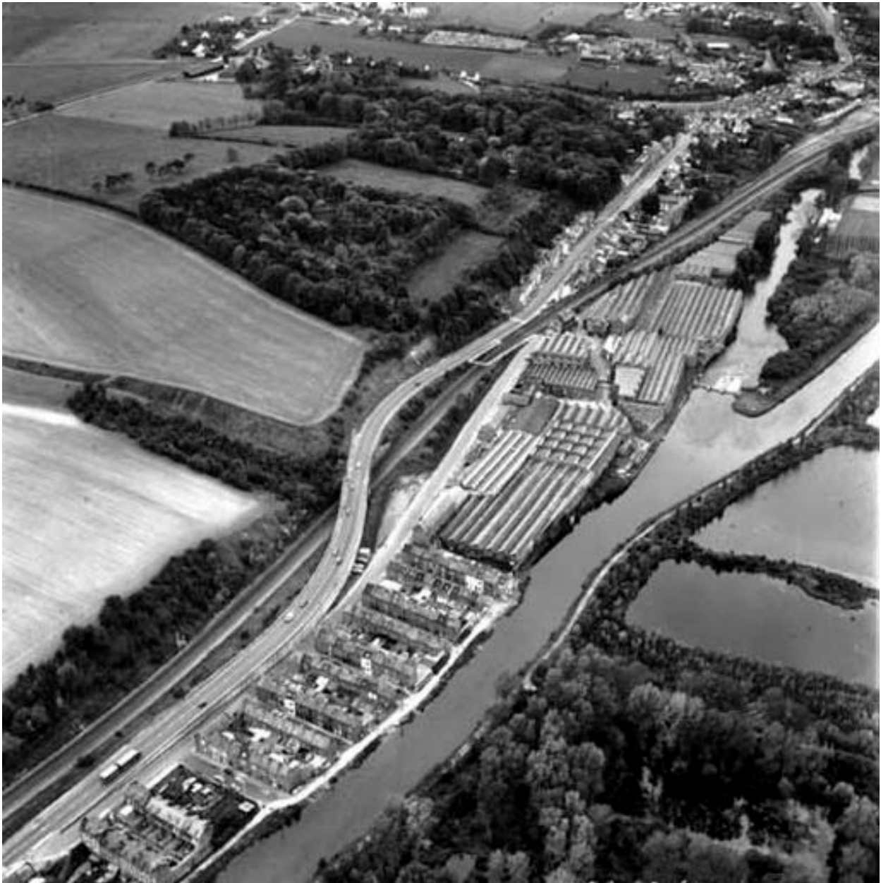
Vue aérienne, flanc sud-ouest.
