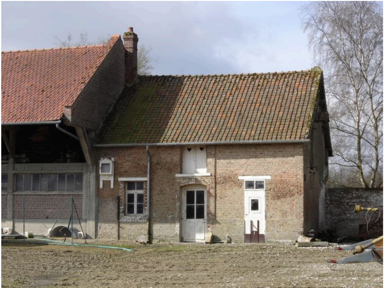
Vue du bâtiment sud.
