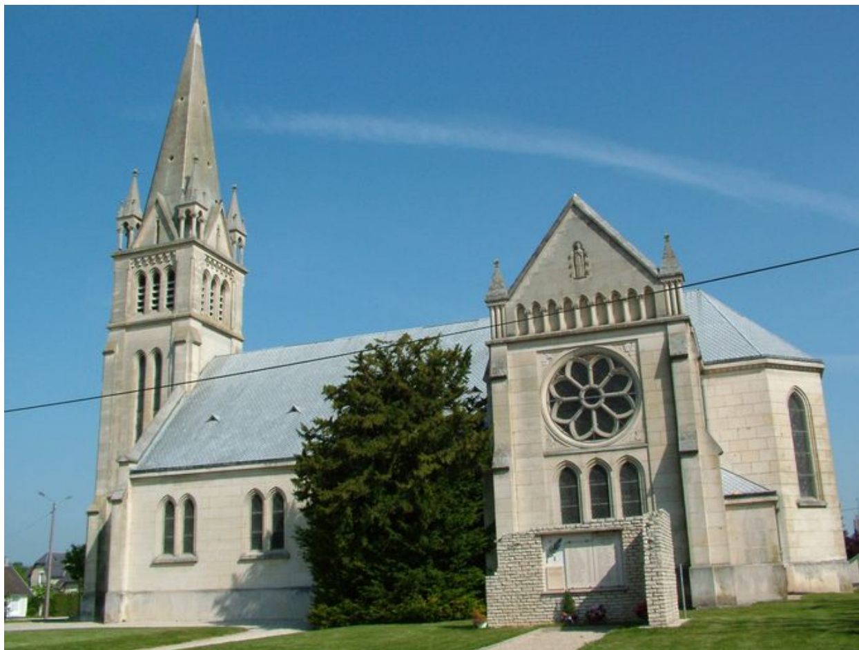
Vue de la face sud.
