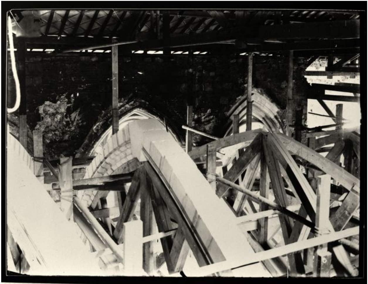
Les voûtes, en cours de reconstruction (photographie de l'entre-deux-guerres).
