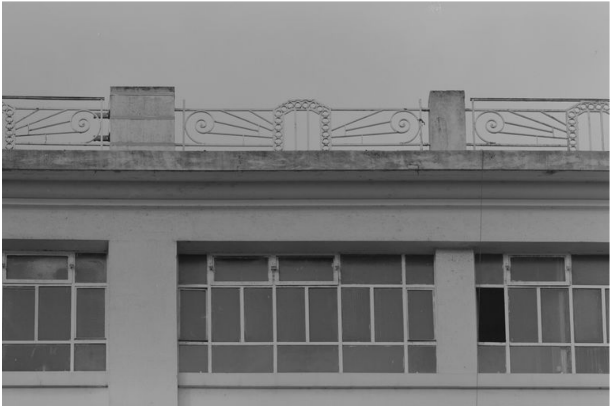
Détail de la balustrade bordant la terrasse.
