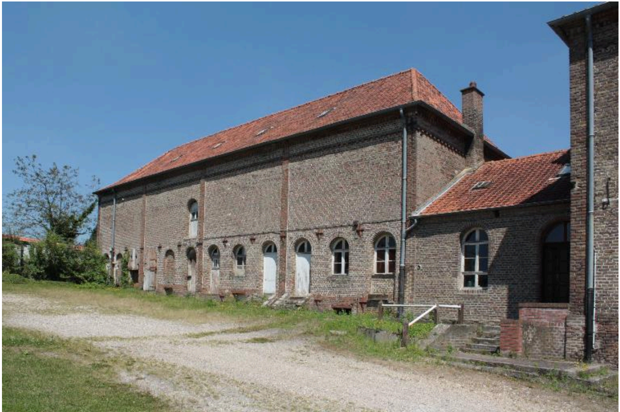
Façade sur cour de la laiterie, vue de trois-quarts.
