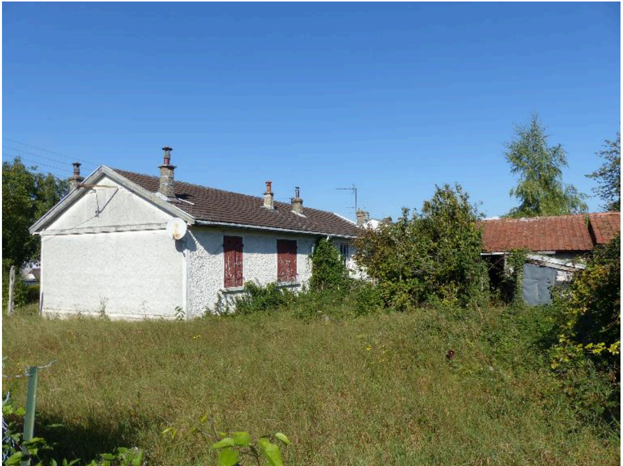
Maison à deux unités d'habitation (type Delorme), rue des Belges, façade postérieure.
