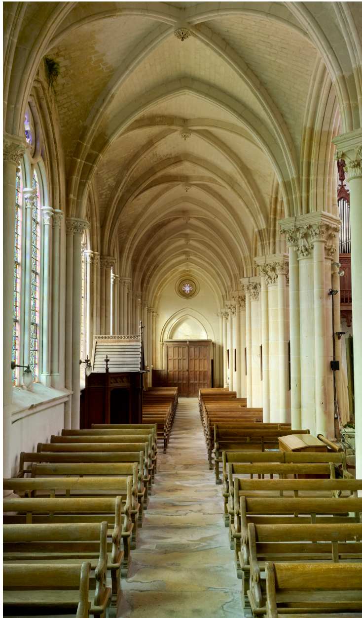
Intérieur, vue du collatéral sud, depuis l'est.
