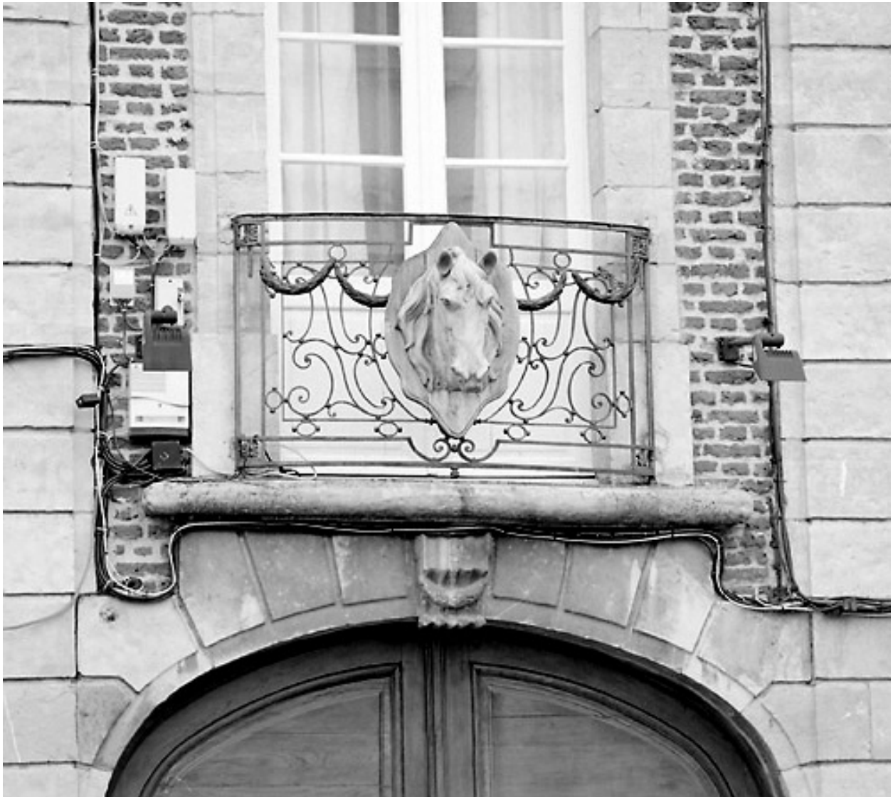
Étage, travée de passage cocher, détail : balcon (la tête de cheval est un ajout des années 2000).
