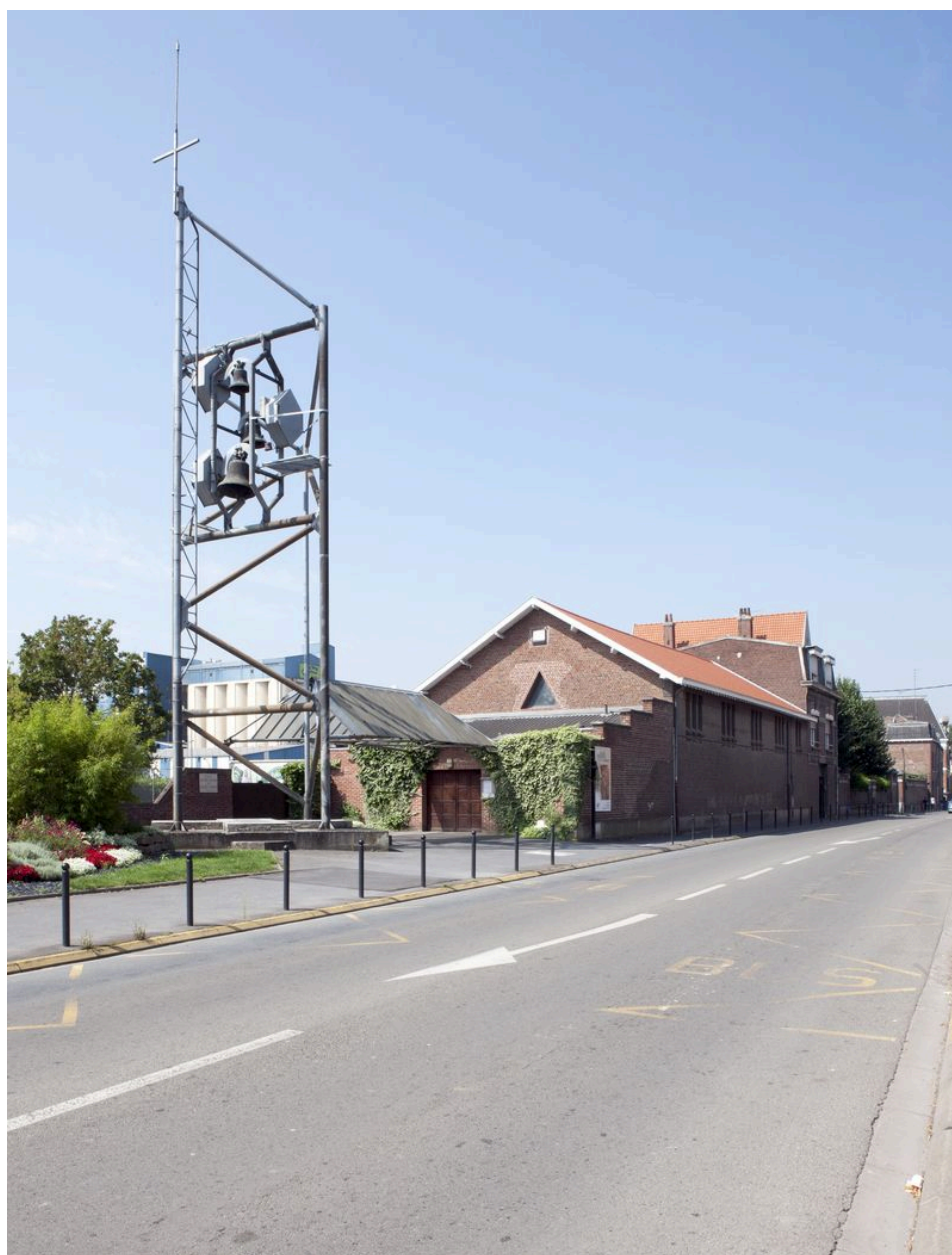
Façade côté nord et clocher.
