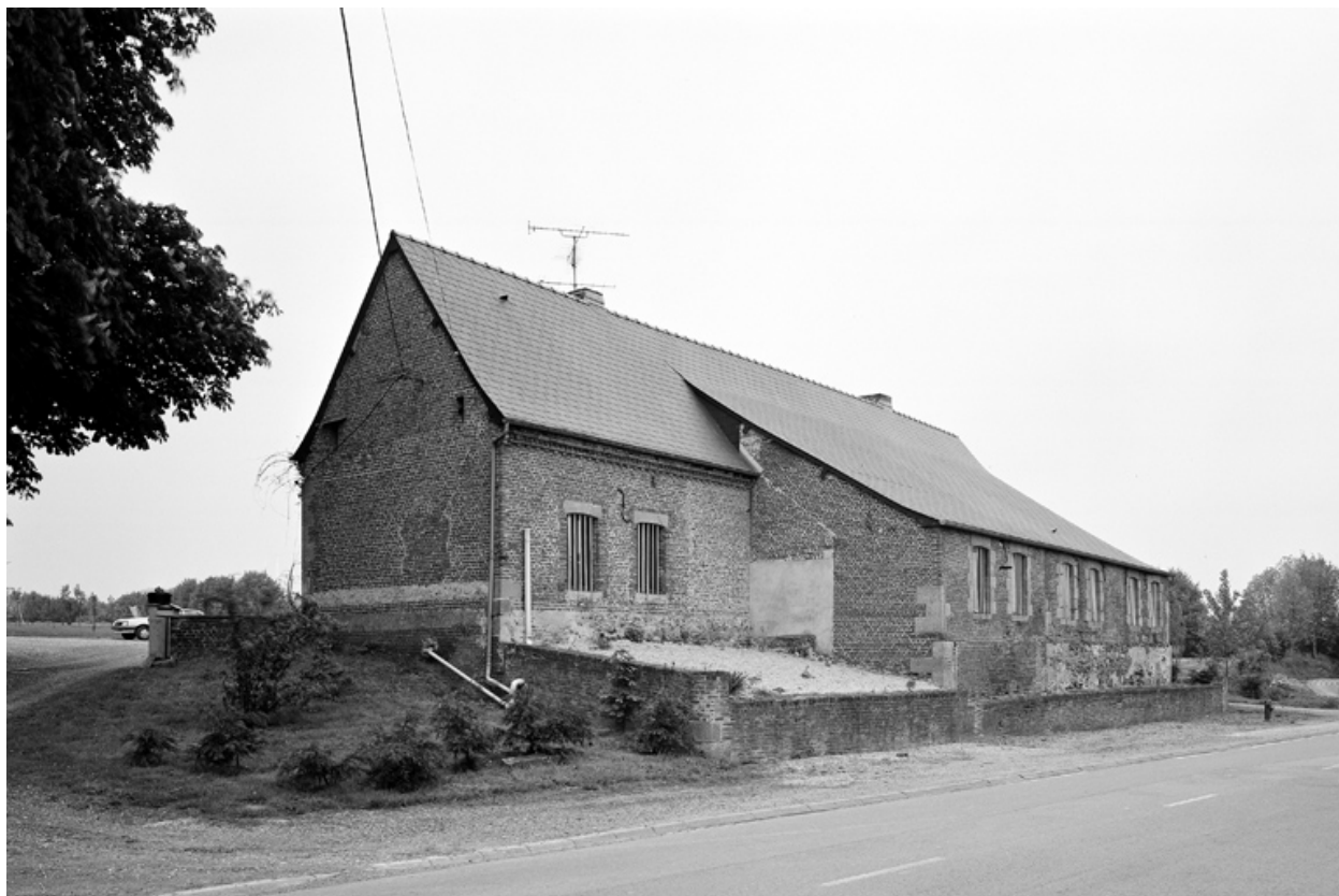
Le logis, depuis le nord-est.
