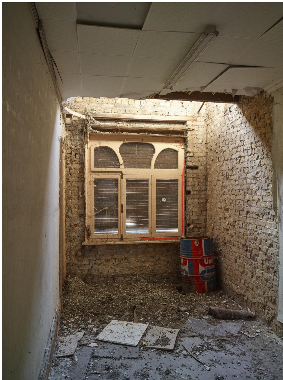
Bureaux : vue d'une des baies.
