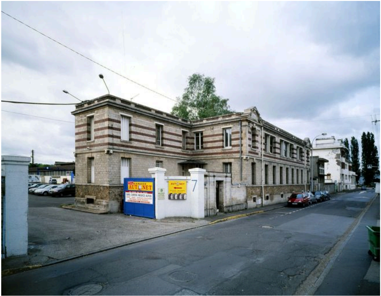
Façade des bureaux et de l'infirmierie rue des Usines.
