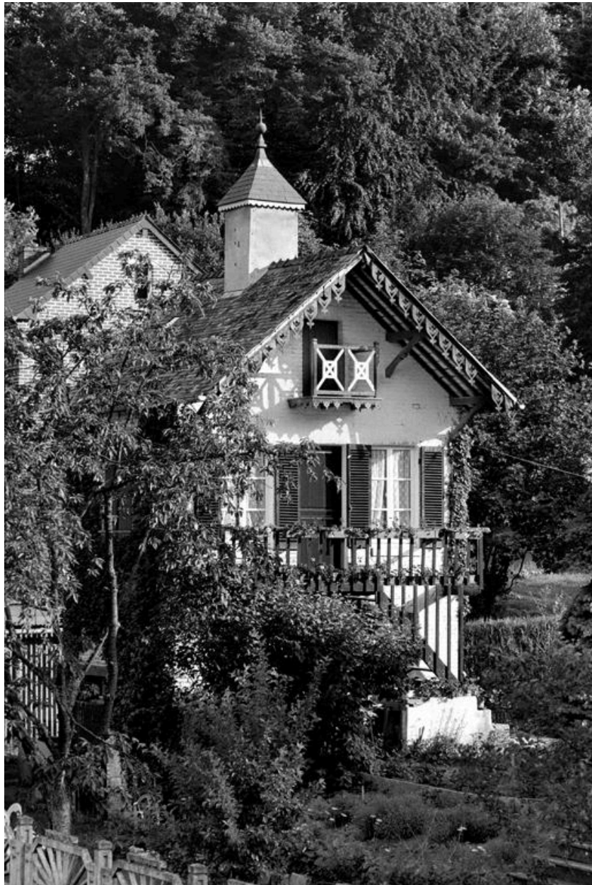
Vue de l'élévation principale sur le jardin.
