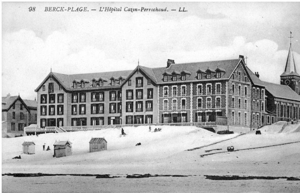
Elévation antérieure, état après la suppression des balcons et terrasses en charpente autour de 1920, vue de trois-quarts droit. Carte postale, 1er quart 20e siècle (coll. part.).
