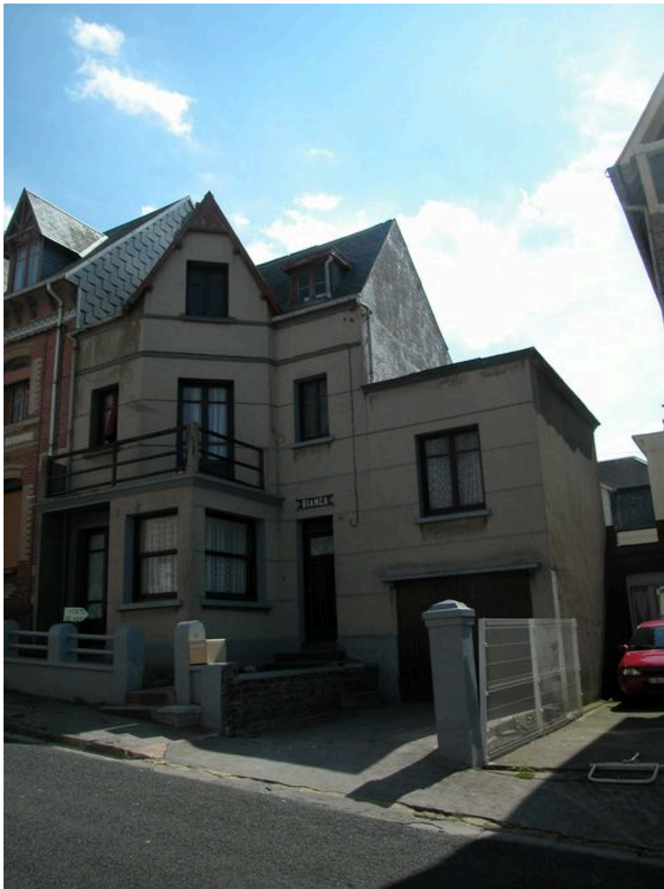
Maison, 6 avenue du Casino (1983 AB 673).
