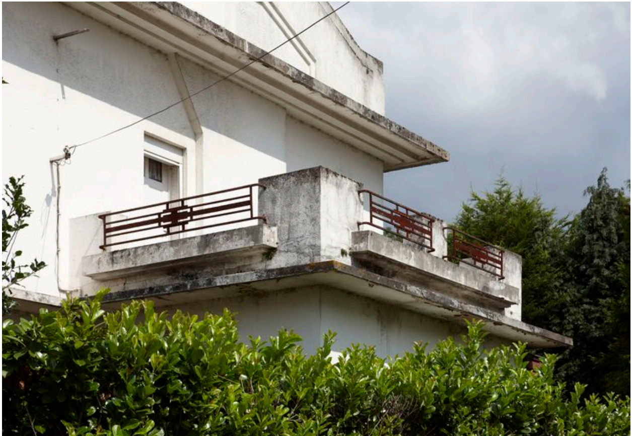
Façade latérale, étage, détail : terrasse et garde-corps.
