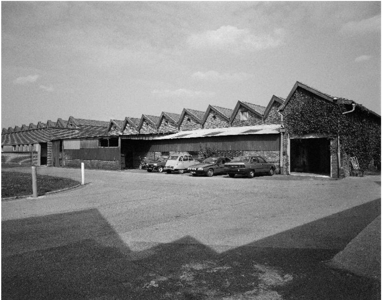
Atelier de fabrication, flanc ouest.
