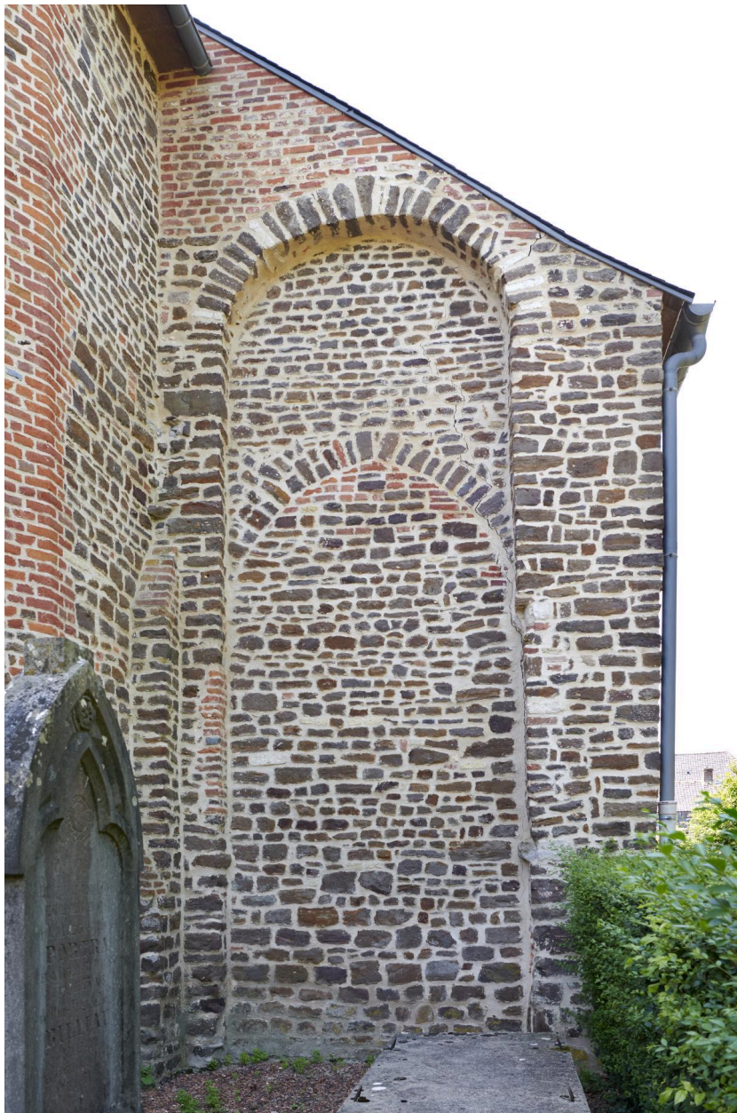
Détail d'une baie rebouchée au niveau du bas-côté nord (à l'arrière de l'édifice).
