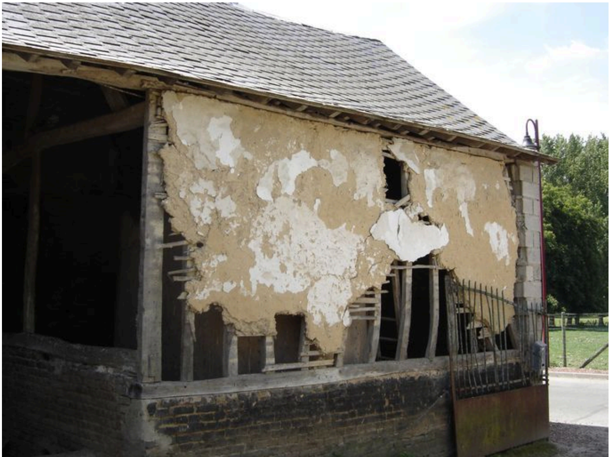
Vue de la grange depuis la cour.
