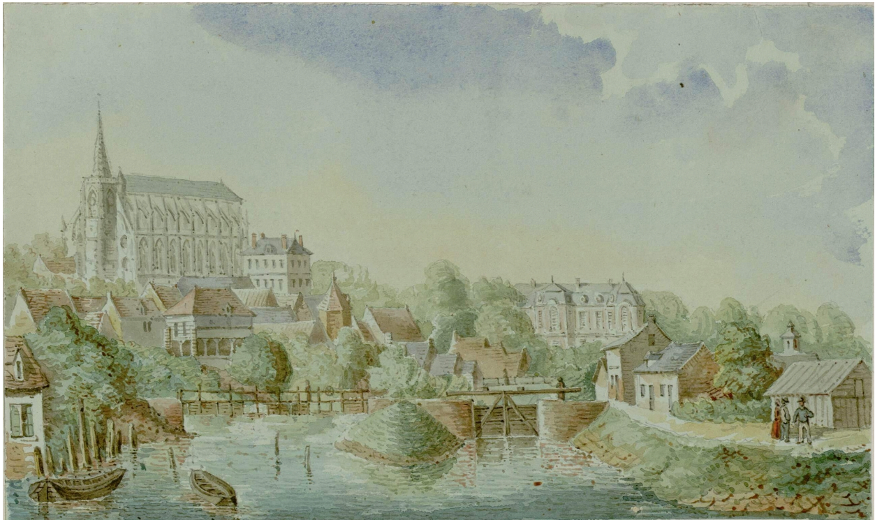
Vue générale de Long, prise du bord de la Somme, par Oswald Macqueron, d'après nature, 3 septembre 1862 (Archives et Bibliothèque patrimoniale d'Abbeville ; Ail. 49).
