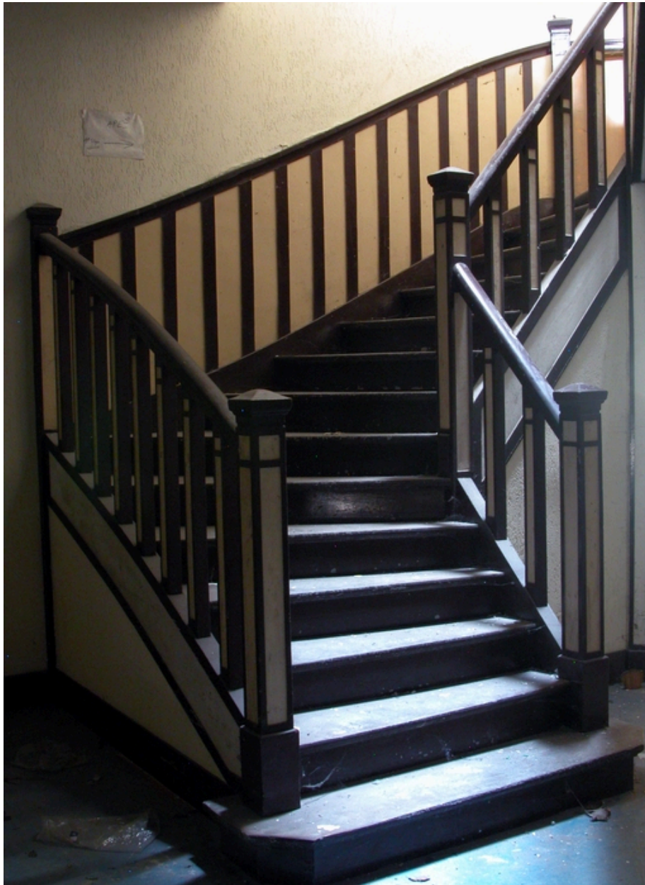
Escalier implanté à l'angle des rues de Mulhouse et Richard-Lenoir (rez-de-chaussée), détail.
