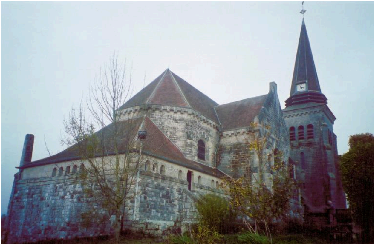
Façade postérieure sud.
