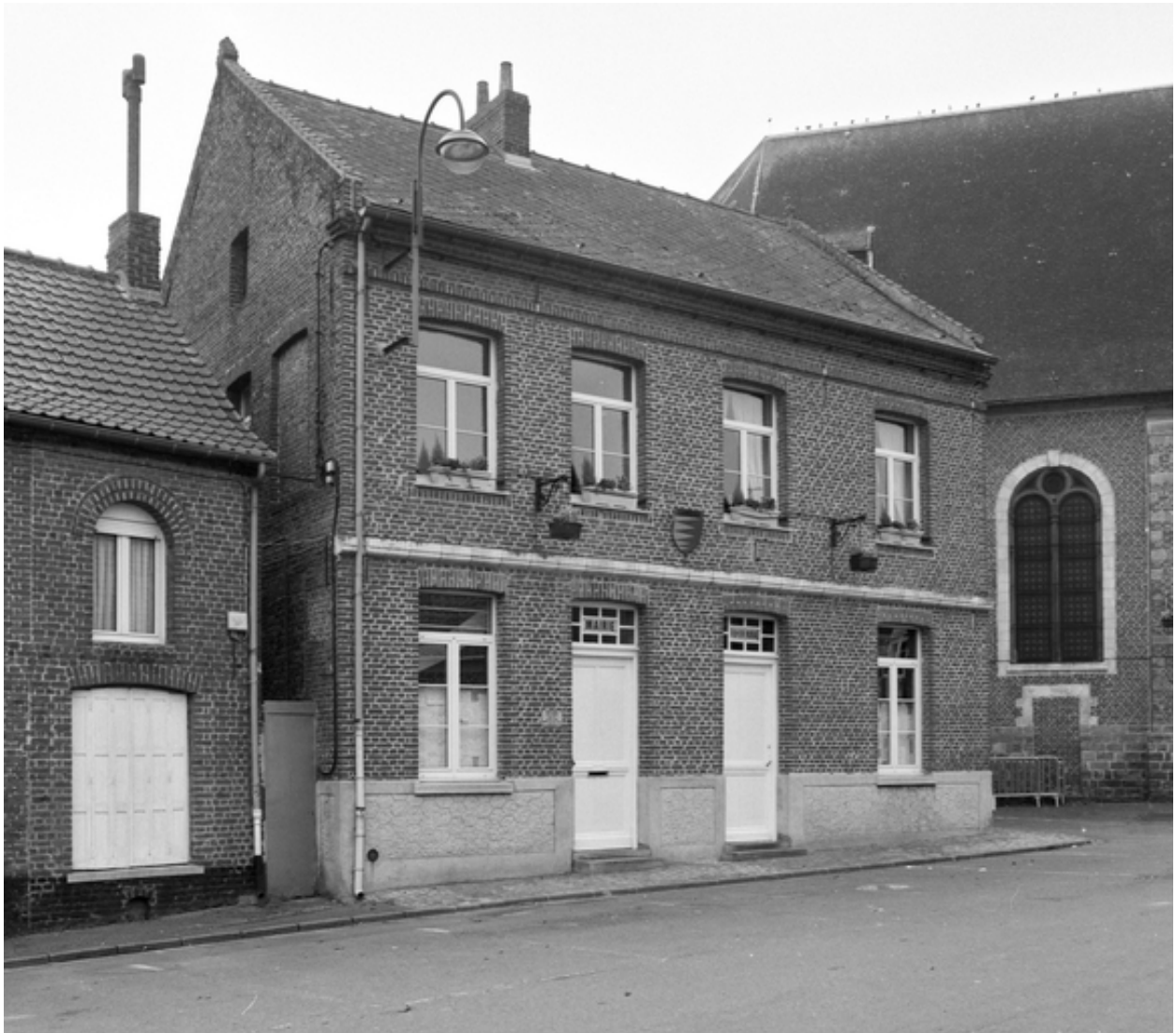
Vue générale de la façade principale depuis la place.
