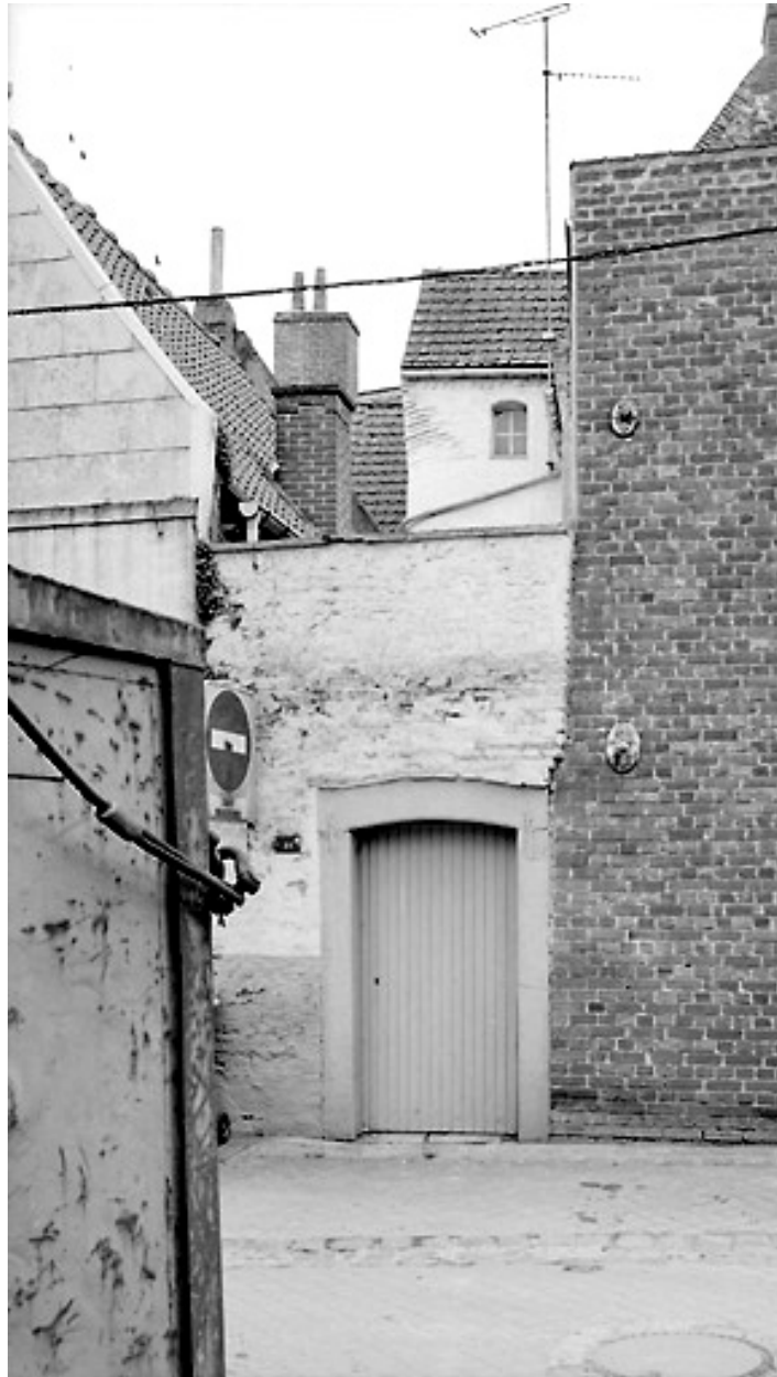
Accès rue Sainte-Barbe : vue sur la partie supérieure de la tourelle d'escalier, état en 2001.
