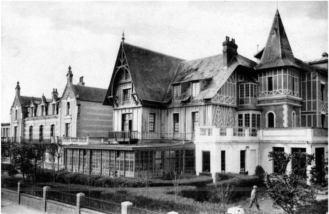
Élévation donnant sur la rue de Lhomel, avec l'ancienne villa, au premier plan sur la droite, et le bâtiment ajouté en 1906-1907, au second plan sur la gauche, vue d'ensemble prise de trois-quarts droit. Carte postale (coll. part.).
