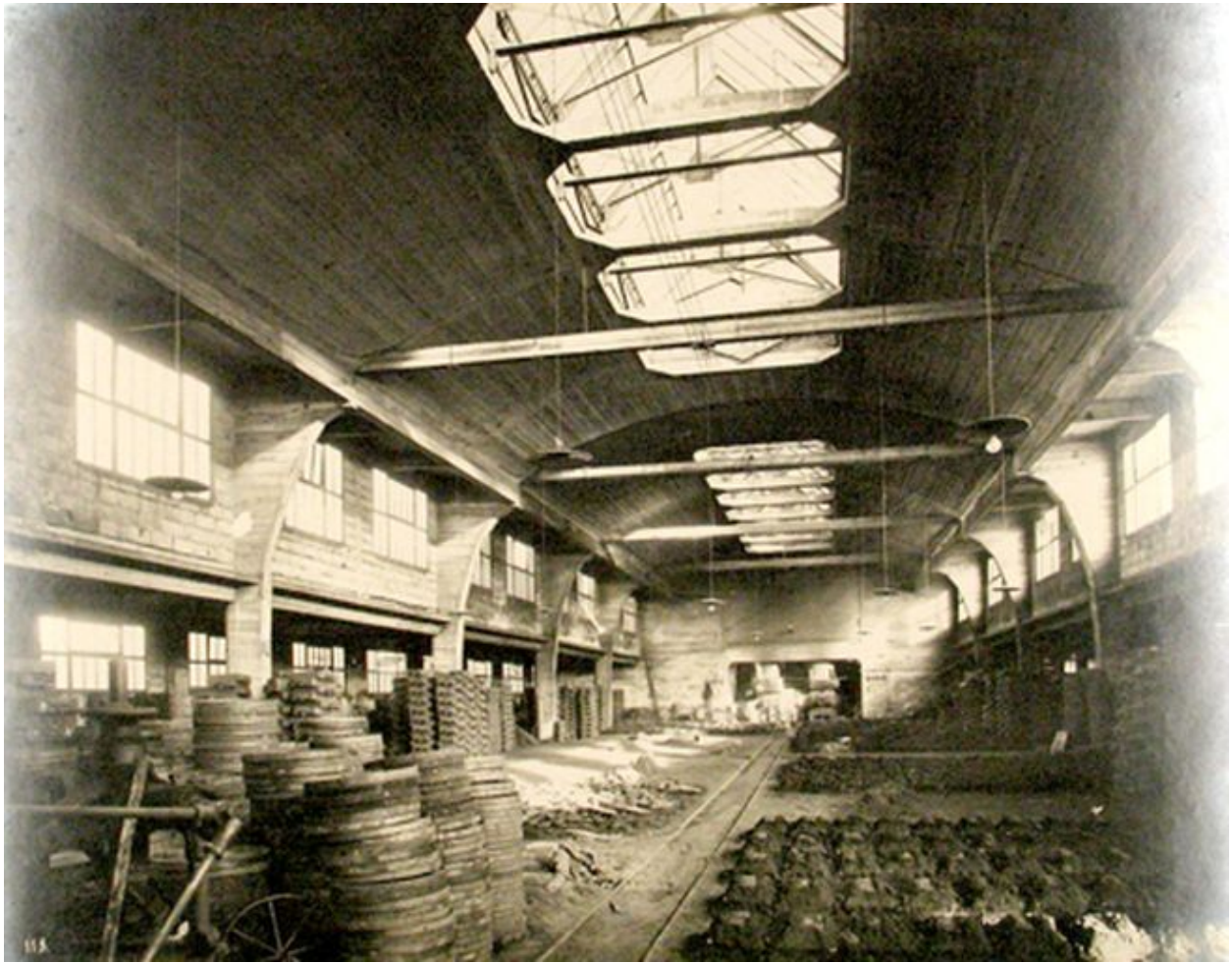
Intérieur de la fonderie construite par les architectes Perret au milieu des années 1920 (IFA ; 535 AP 651/12).
