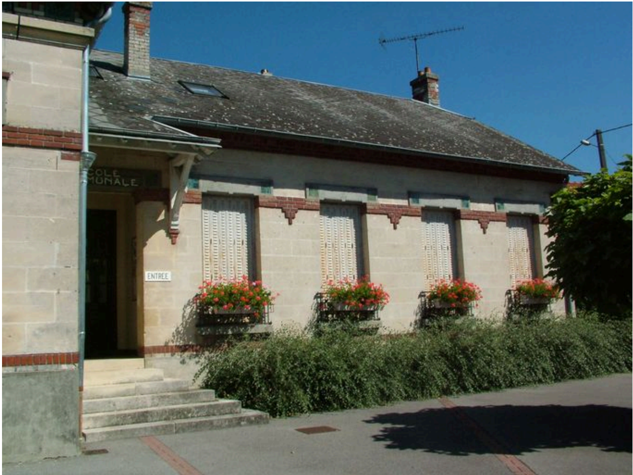
Vue des bâtiments scolaires.
