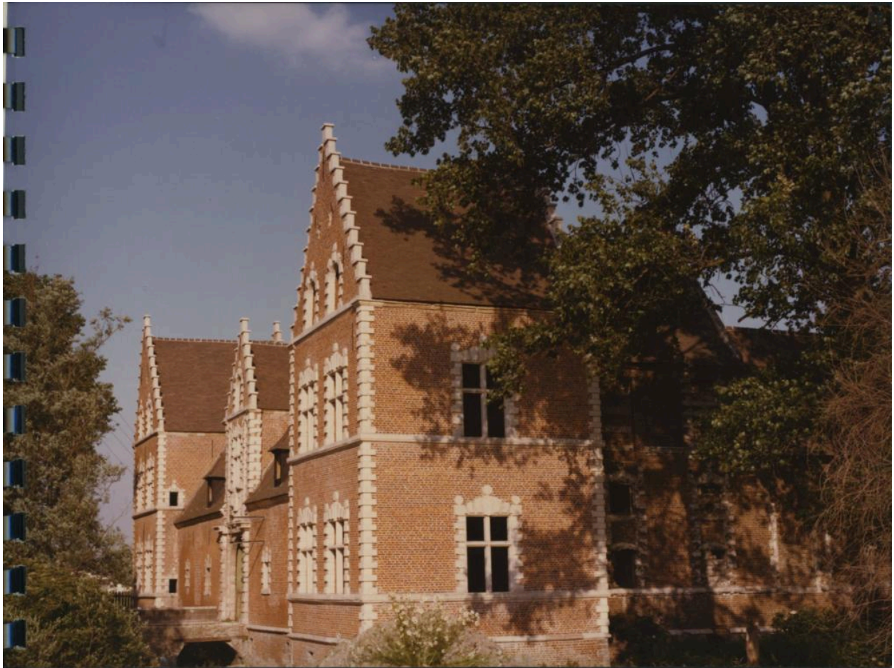
En 1978 : le château de Flers (angle nord-ouest) (AC Villeneuve d'Ascq, 16W3).
