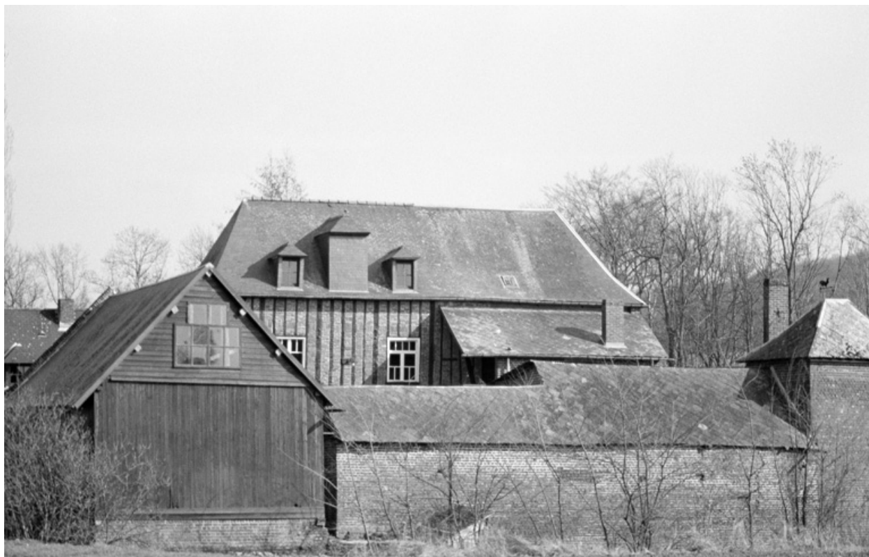
Ensemble des bâtiments, vus de l'ouest.
