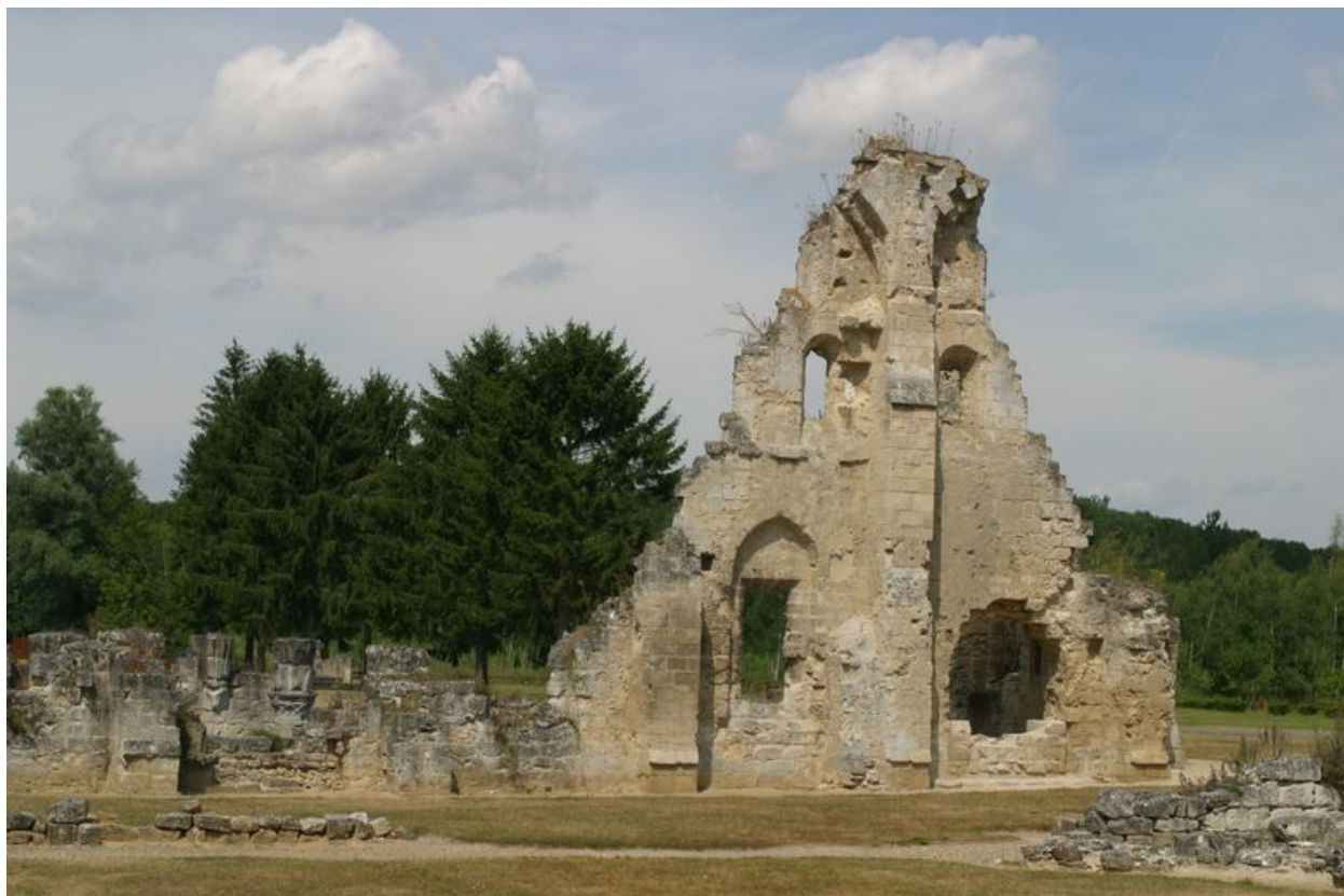
Vue partielle du bâtiments des convers.
