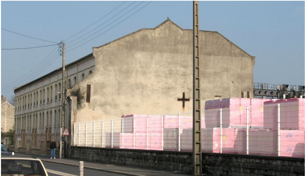
Mur pignon ouest des logements.
