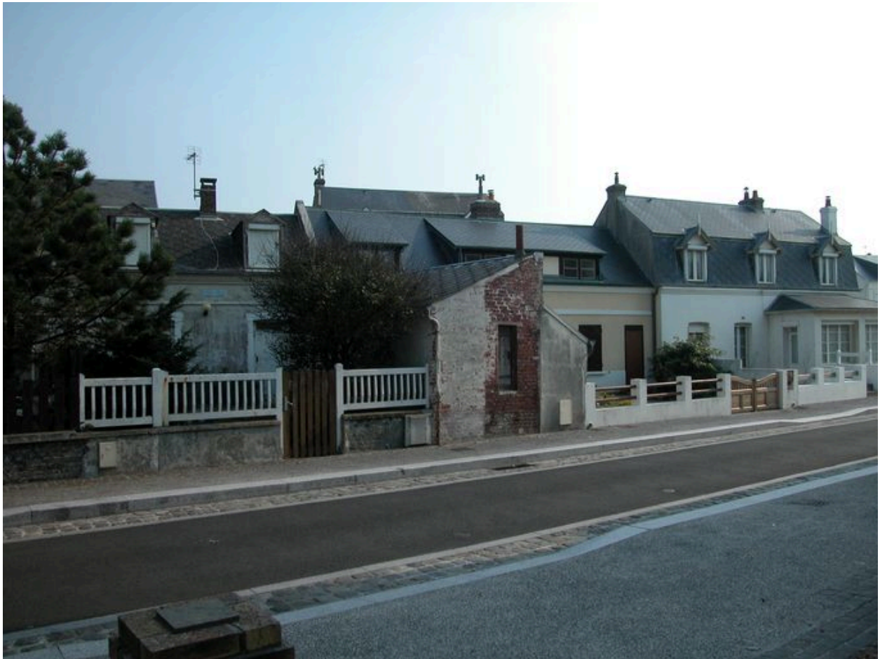
Façade postérieures sur la rue Joffre des maisons de la rue Duquesne.
