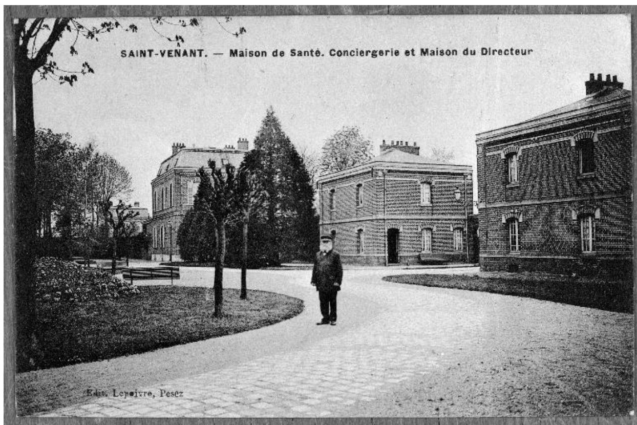
Pavillons de la conciergerie encadrant l'entrée principale, élévations postérieures, vue de trois quarts droit montrant l'habitation du directeur dans le fond (coll. part.).
