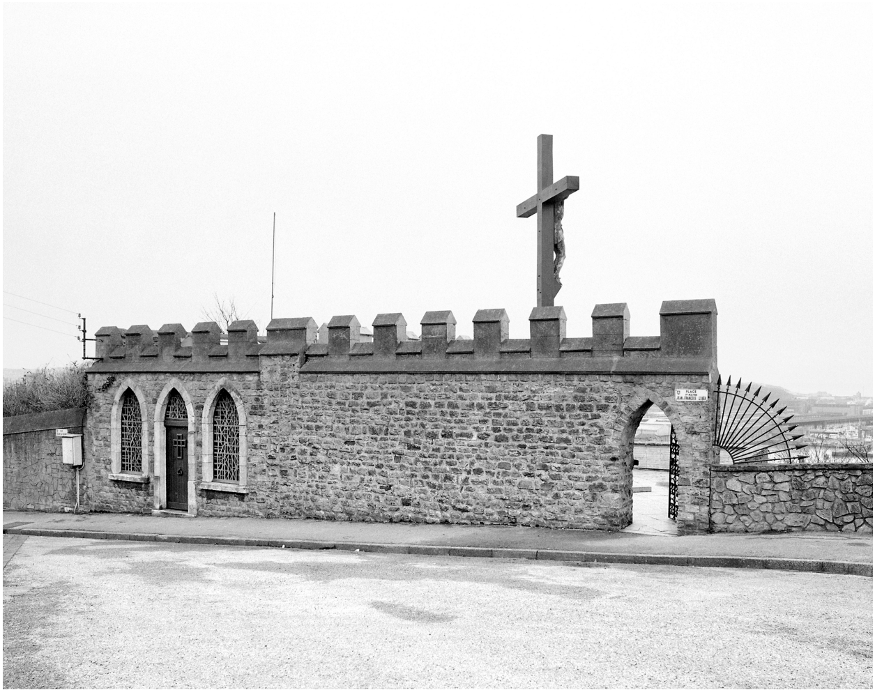
Vue d'angle sur voie.
