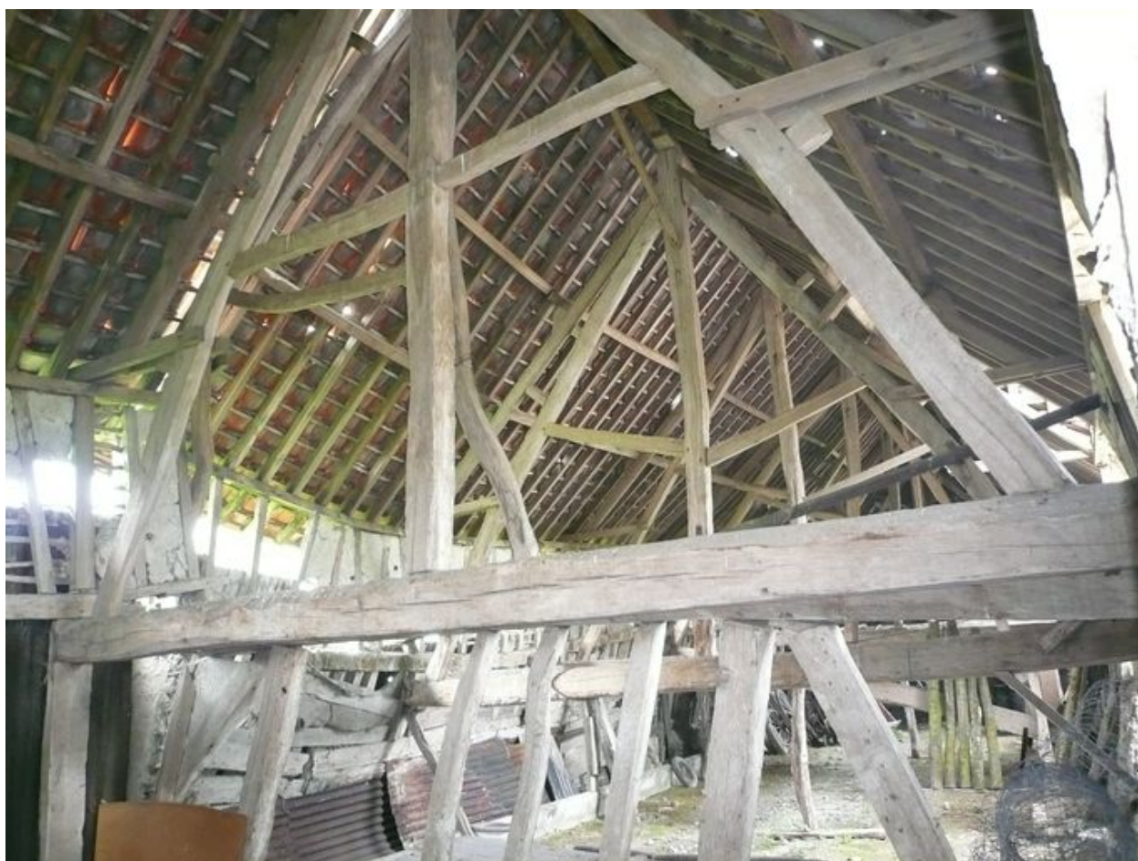
Vue intérieure de la partie grange.
