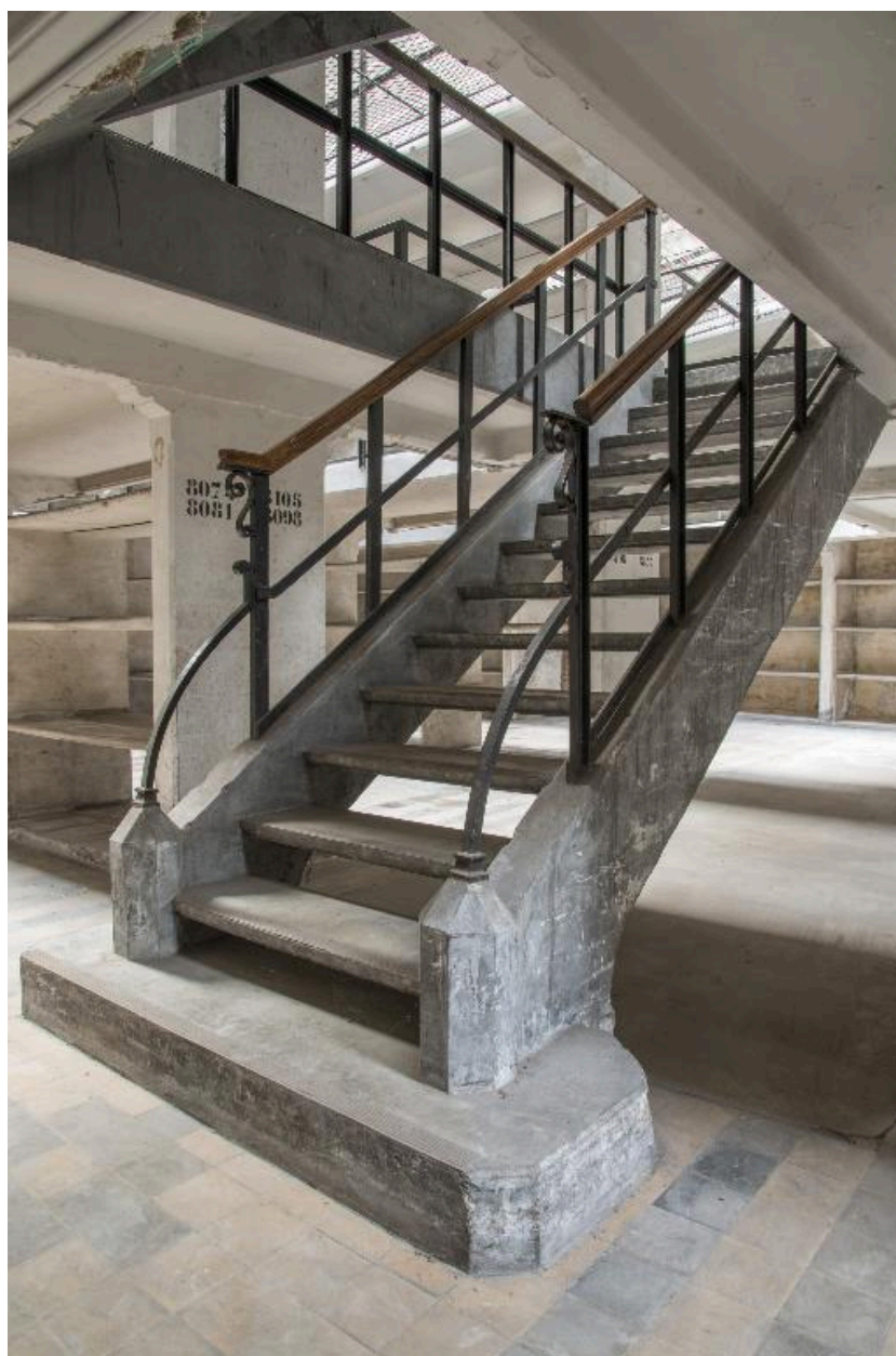
Bâtiment du dépôt, rez-de-chaussée : vue de trois quarts de l'escalier, vaisseau 2.
