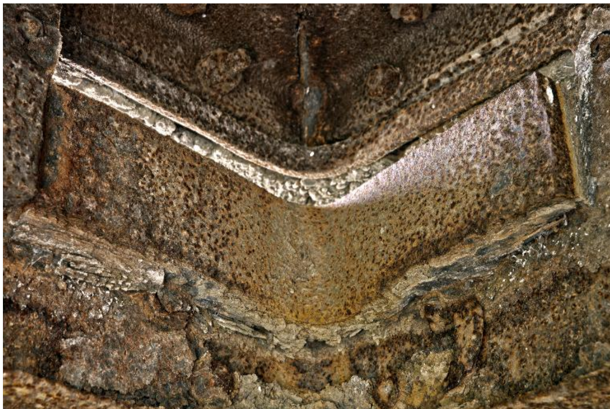
Observatoire casematé, détail intérieur
