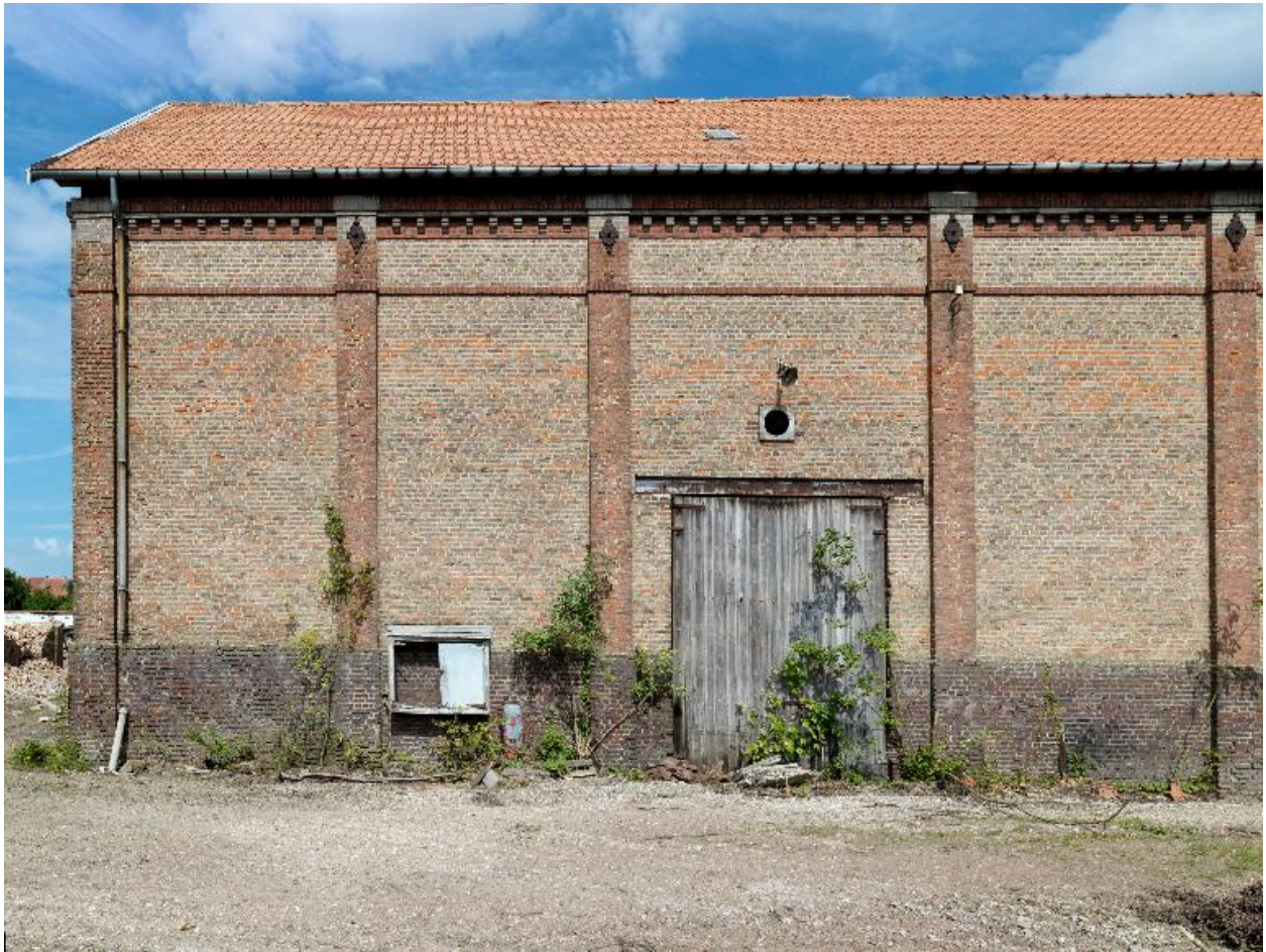
Elévation longitudinale partielle des entrepôts, juillet 2012.
