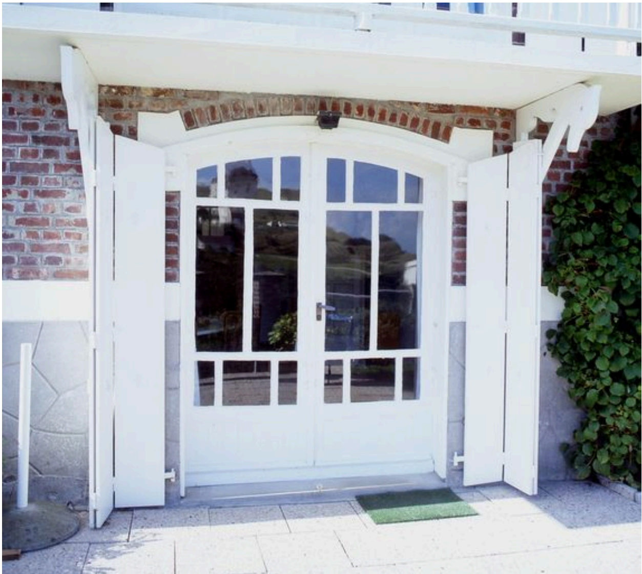
Détail de la baie donnant accès à l'étage de soubassement, côté mer.
