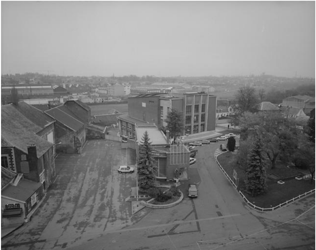
Vue aérienne de l'ensemble centre culturel et hôtel de ville, prise du clocher de l'église.
