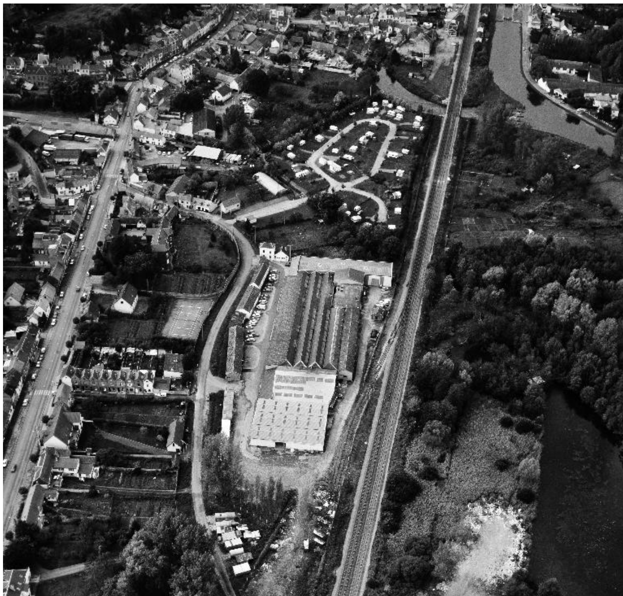
Vue aérienne, flanc est.
